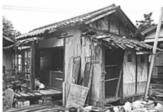
危険な状況にある空き家
