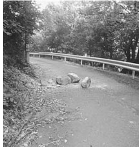
落石防止対策が急がれる危険箇所 (請願現地)
