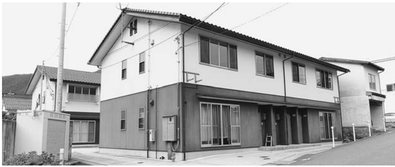
空き部屋のある町営住宅
