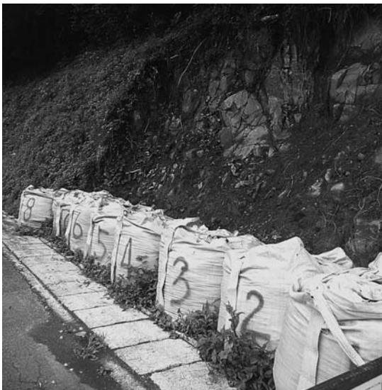
土のうによる落石対策
