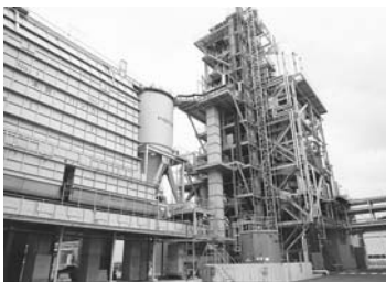
木質バイオマス発電所
