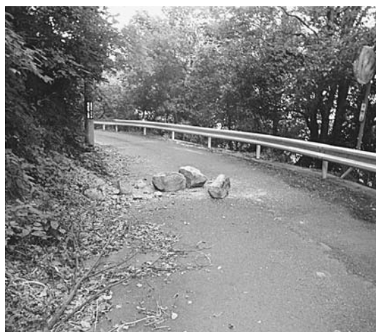
町道の落石状況
