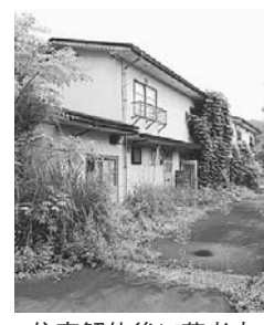
住宅解体後に若者定住住宅の建設予定の本郷住宅
