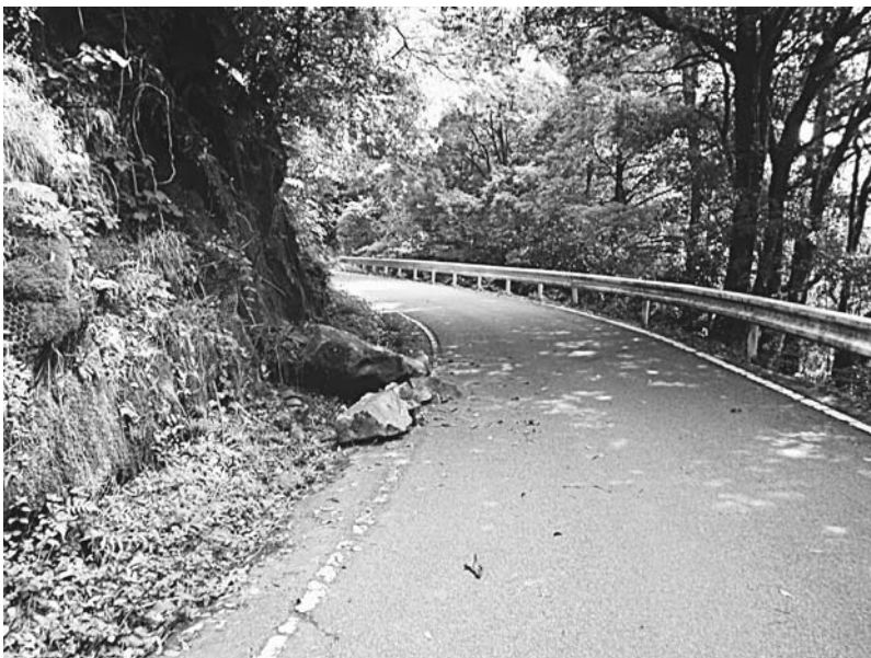
落石がたえない町道
